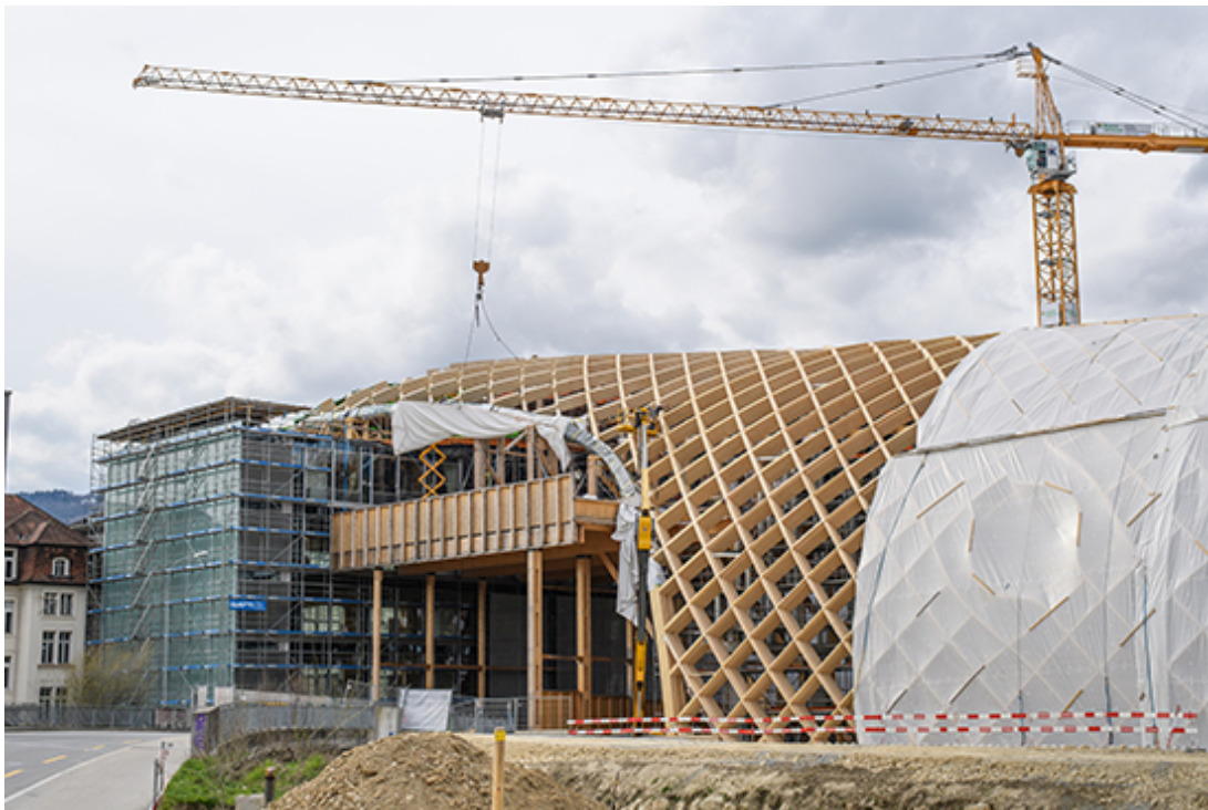
Baustelle Hauptsitz der Swatch Group, Biel, Shigeru Ban Architects 2018
